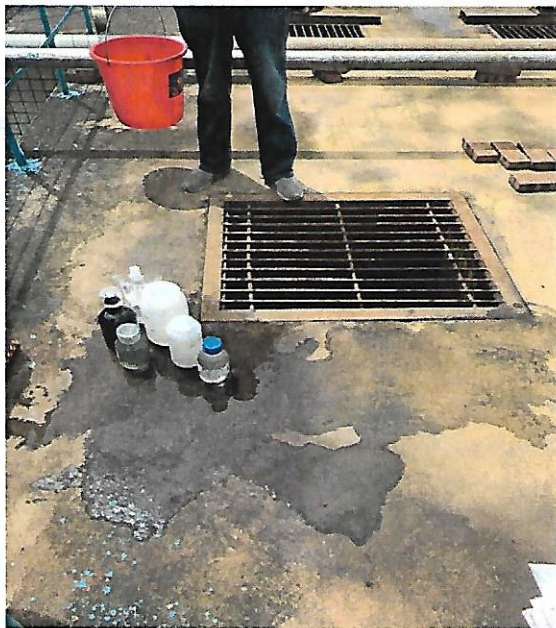
污水厂进水口
