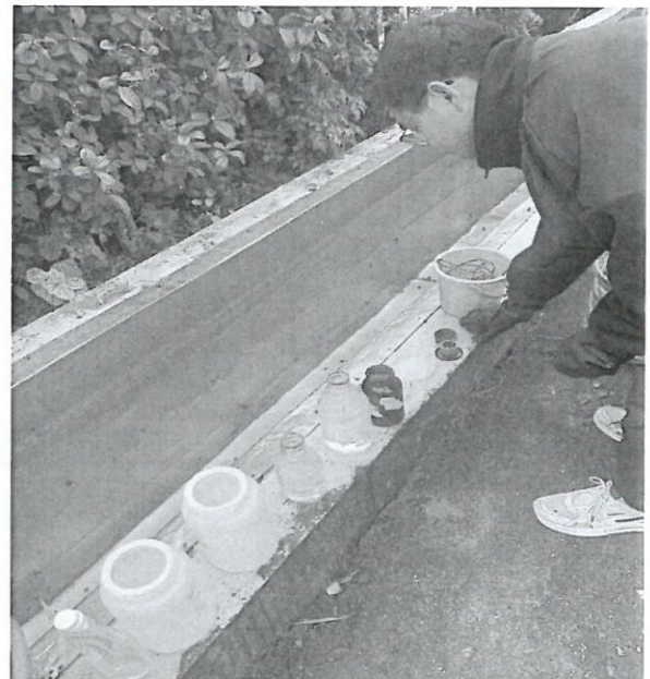
污水厂排水口 (DW001)
